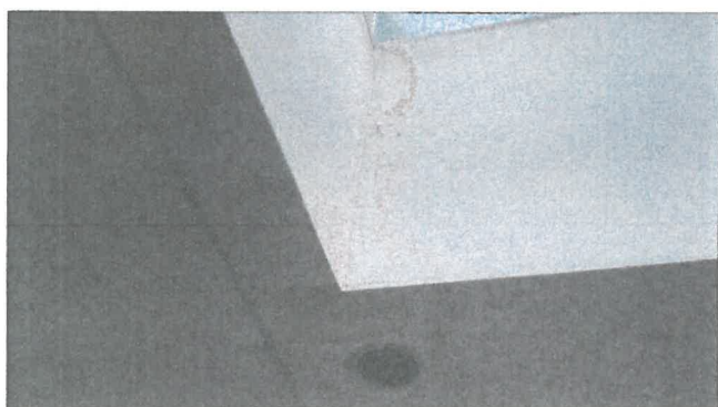
Fot. Nr 13+16. Zacieki na suficie klatki schodowej.
