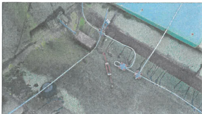
Fot. Nr 11+12. Widok uszkodzonej instalacji odgromowej na dachu sali sportowej.
