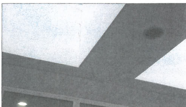
Fot. Nr 13+16. Zacieki na suficie klatki schodowej.
