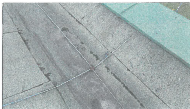
Fot. Nr 11+12. Widok uszkodzonej instalacji odgromowej na dachu sali sportowej.
