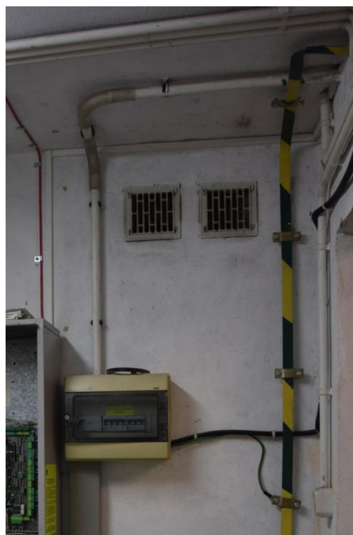
Foto 13. Zdjęcie poglądowe – główne zasilanie dźwigu
