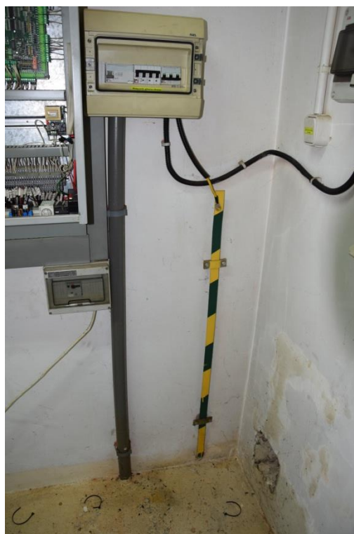
Foto 23. Zdjęcie poglądowe – główne zasilenie dźwigu
