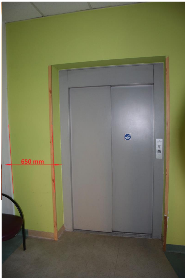
Foto 24. Zdjęcie poglądowe – dźwig D1, drugie piętro, przewidywane miejsce dla instalacji maszynowni dźwigu
