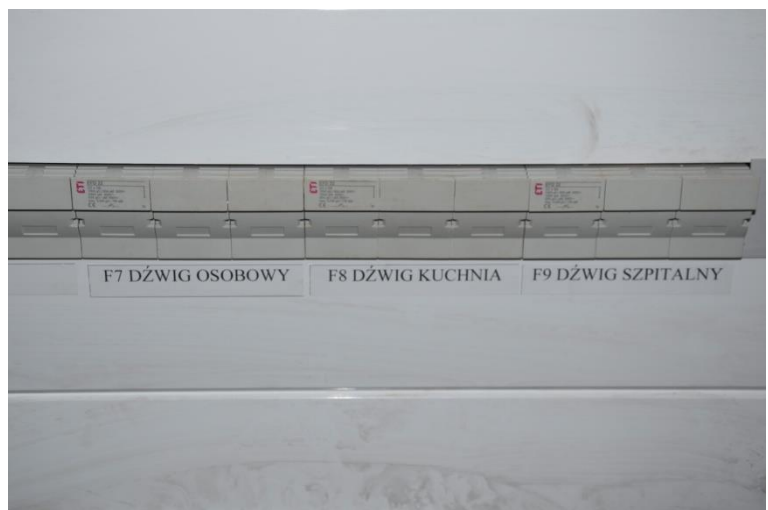
Foto 27. Zdjęcie poglądowe – zasilanie dźwigów w RG
